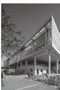
新庁舎北西側からの外観
