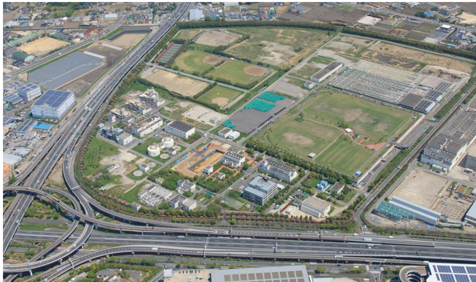
図 3-3 中川水循環センター
