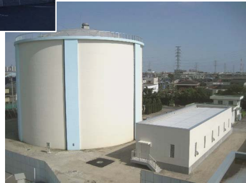
～No. 2 PC 配水池とポンプ室～
