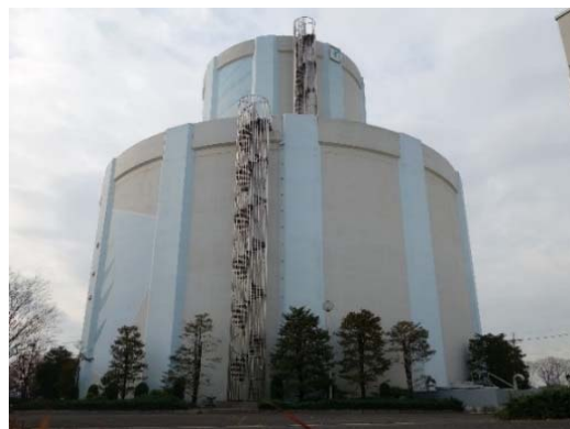
～南部配水場 PC配水池～
