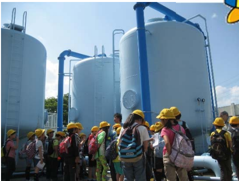
～出前講座 水道施設の案内の状況～
