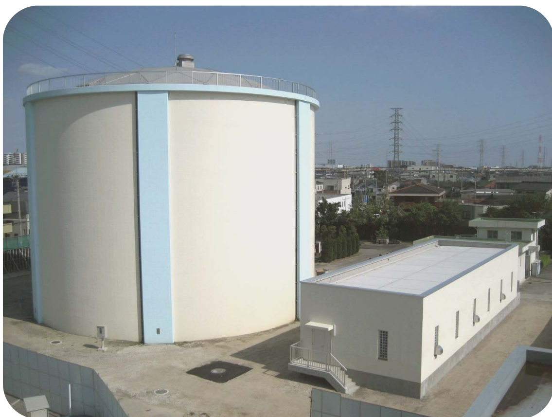
No.2PC 配水池と新ポンプ室（中央浄水場）
