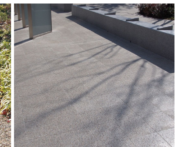
透水性平板舗装
