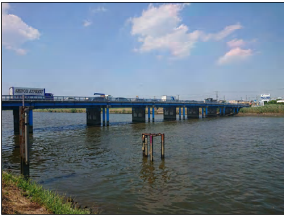
架け替えが予定されている八条橋
