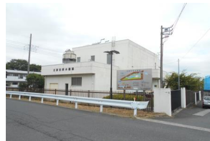
古新田ポンプ場
