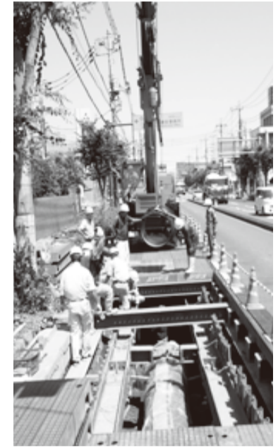
<第1期工事の施工状況>(管種: NS形ダクタイル鋳鉄管 口径: φ800mm)
