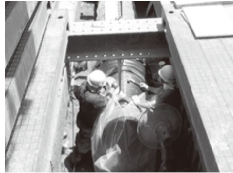
<第1期工事の施工状況>(管種: NS形ダクタイル鋳鉄管 口径: φ800mm)
