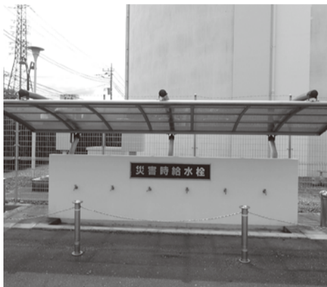
▲中央浄水場災害時給水栓
