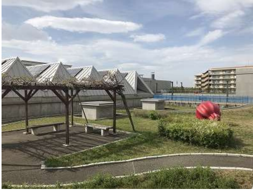
屋上緑化（立川市）
