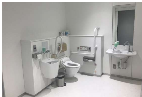
多目的トイレ（水戸市）
