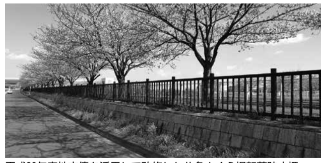
平成28年度地方債を活用して改修した八条さくら堤転落防止柵
