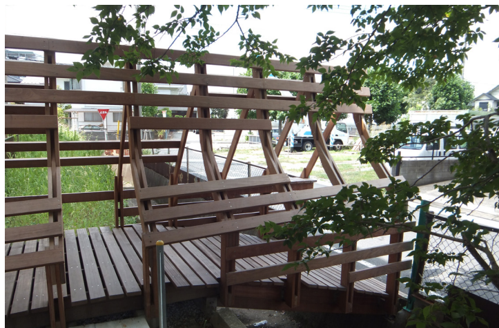
▲完成した会所橋
