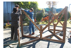
▲組み立て作業
