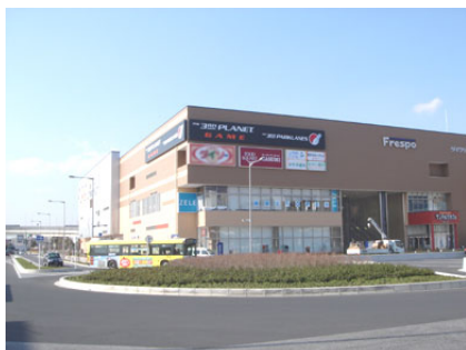
▲八潮駅北口に整備中の商業施設
