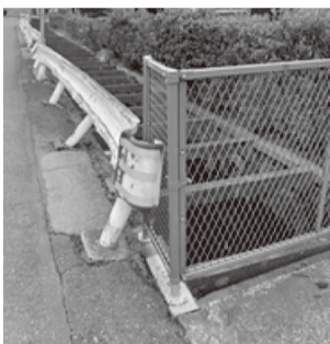
(※) 転落防止柵が設置された水路
