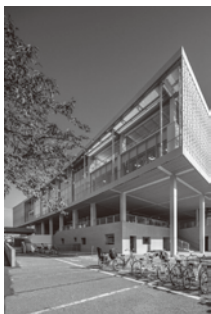
新庁舎北西側からの外観
