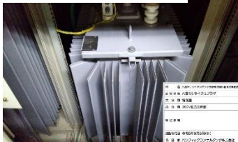
変圧器 (照明用単相主幹盤内)
