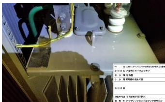
変圧器 (照明用単相主幹盤内)
