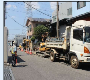
下水道工事の様子
