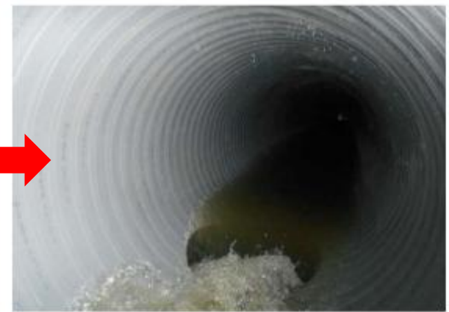
管渠更生後状況
