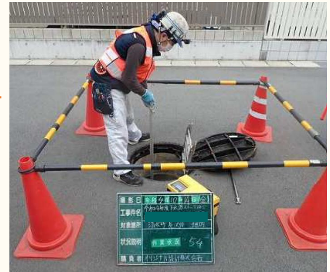
マンホールから管口カメラを用いた点検作業の様子
