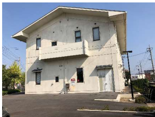
西袋中継ポンプ場(汚水ポンプ場)外観
