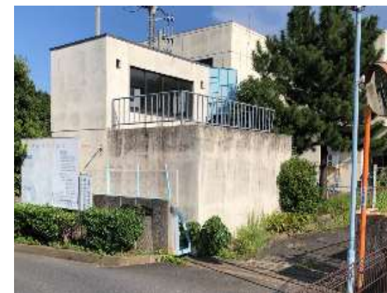
南後谷ポンプ場(雨水ポンプ場)外観
