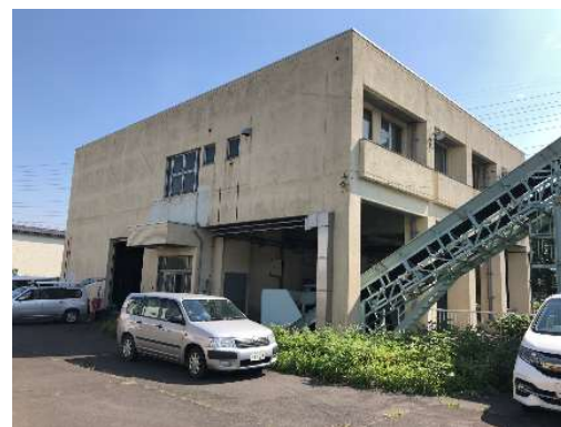
西袋ポンプ場(雨水ポンプ場)外観
