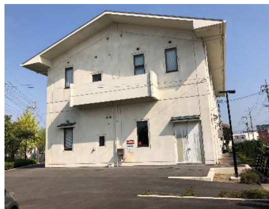
西袋中継ポンプ場(汚水ポンプ場)外観
