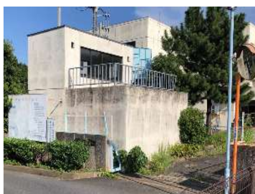
南後谷ポンプ場(雨水ポンプ場)外観
