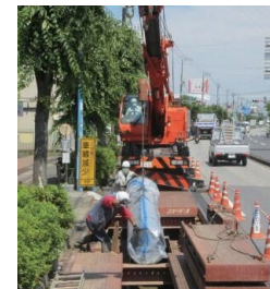
口径600mmの大口径の管を布設している様子
