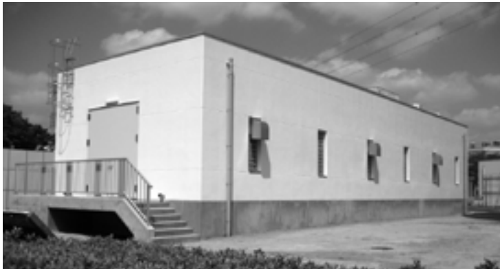
▼完成したポンプ室
