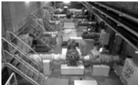
◀ポンプ設備工事の状況
