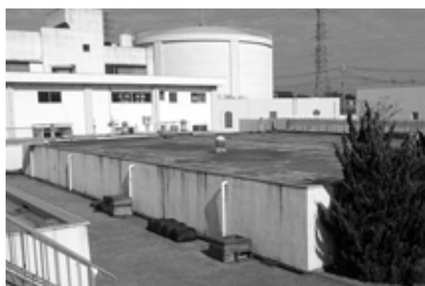
既設の配水池(平成29～30年度撤去)
