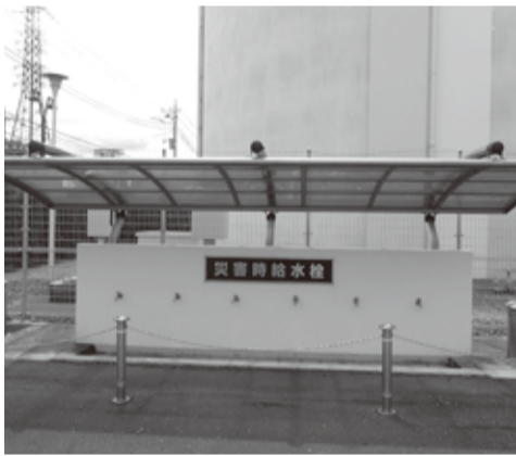
▲中央浄水場災害時給水栓
