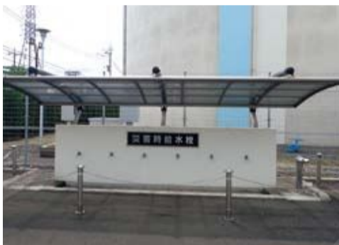
災害時給水栓
