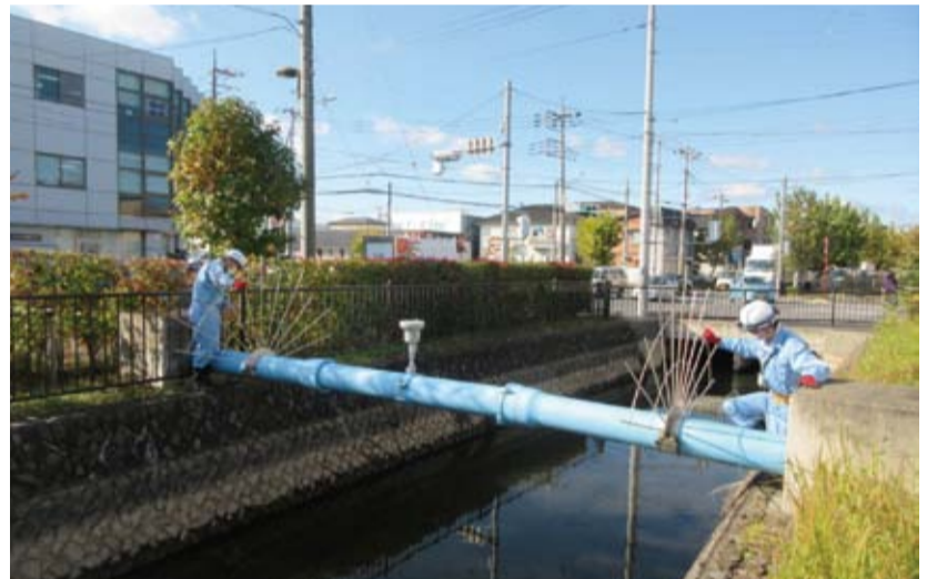
水管橋の点検(八條小橋下流部)
