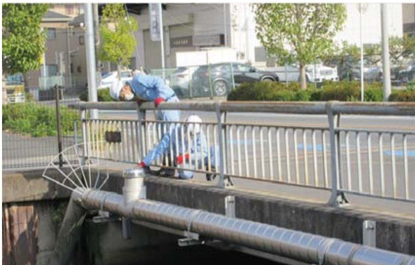
水管橋の点検(伊草天神橋)
