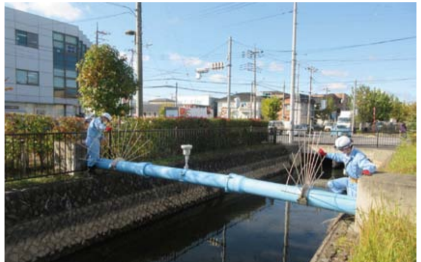
水管橋の点検(八條小橋下流部)
