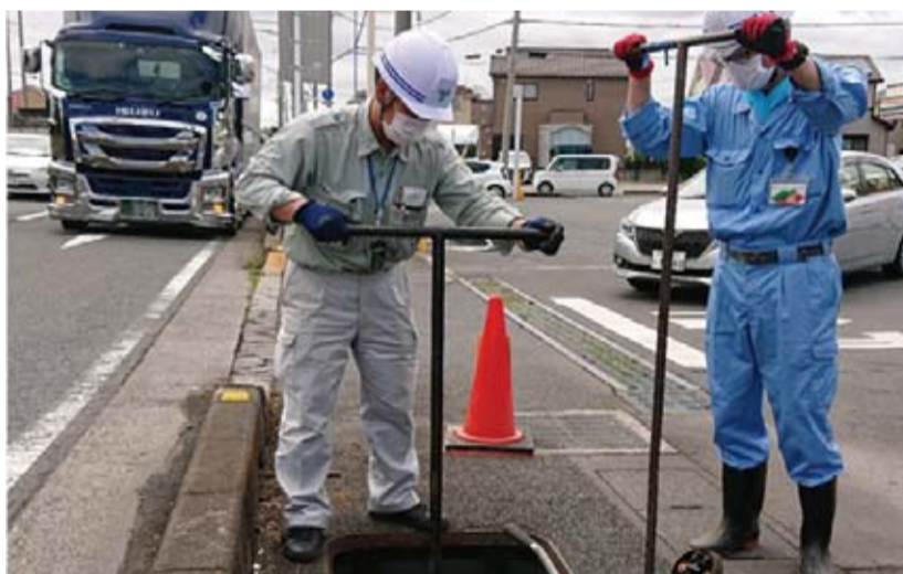
草加市との相互連絡管の共同点検(大字西袋)
