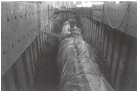
＜施工状況＞（管種：N S形ダクタイル鋳鉄管 口径：φ600mm）
