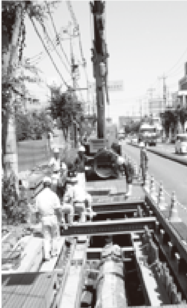
＜施工状況＞（管種：N S形ダクタイル鋳鉄管 口径：φ600mm）
