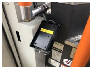
▲前扉付近の赤外線センサー
