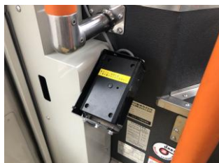
▲前扉付近の赤外線センサー
