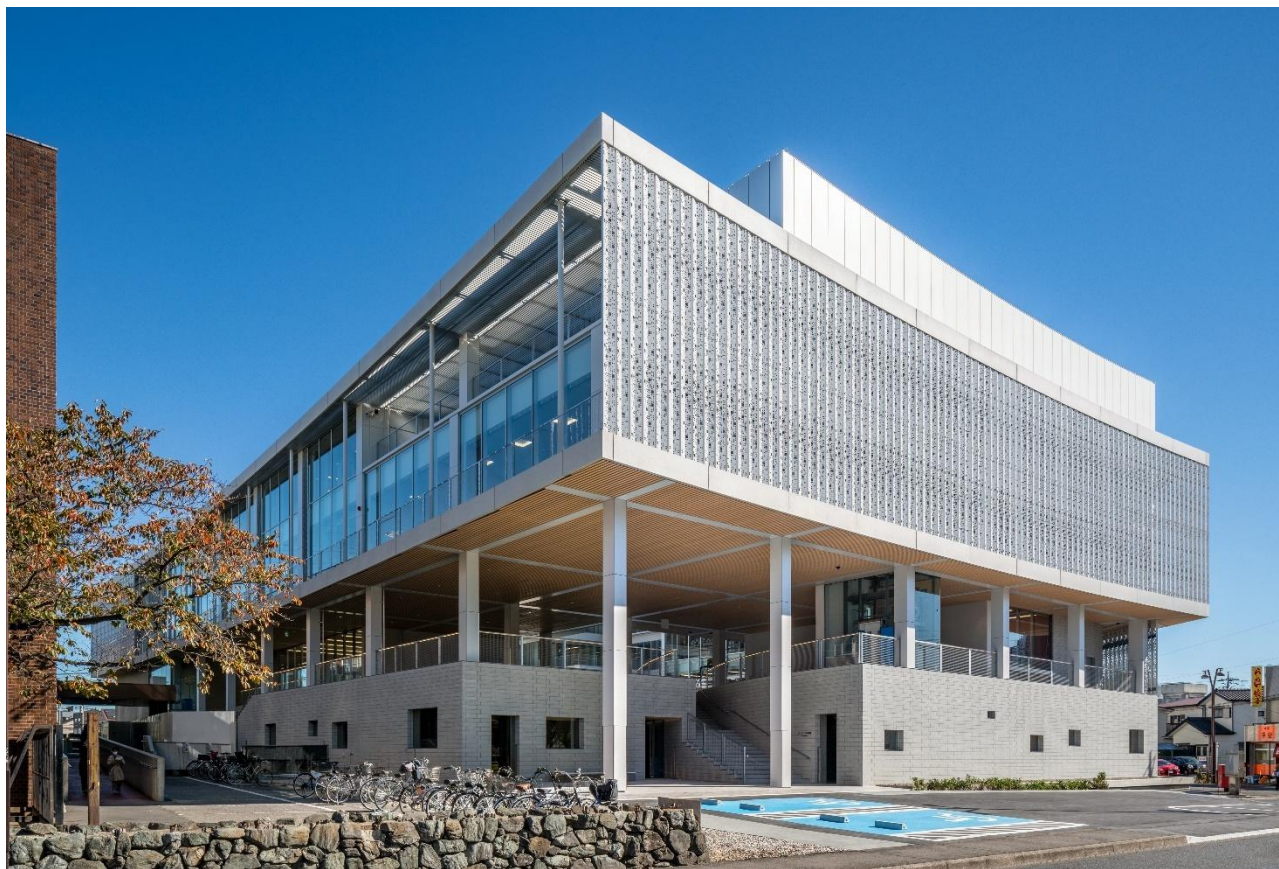
八潮市役所新庁舎
