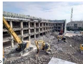
旧庁舎解体の様子
