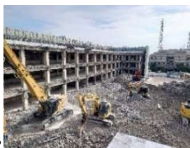
旧庁舎解体の様子
