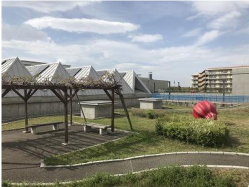
屋上緑化（立川市庁舎）
