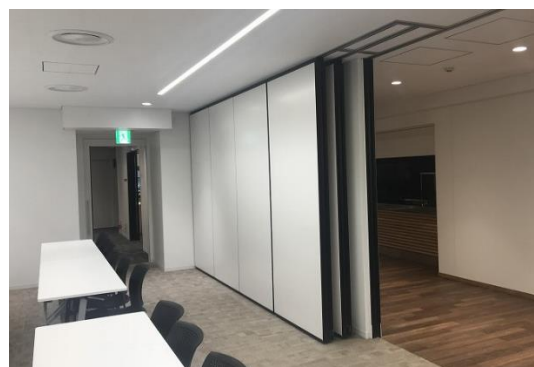
会議室のパーティション（水戸市庁舎）
