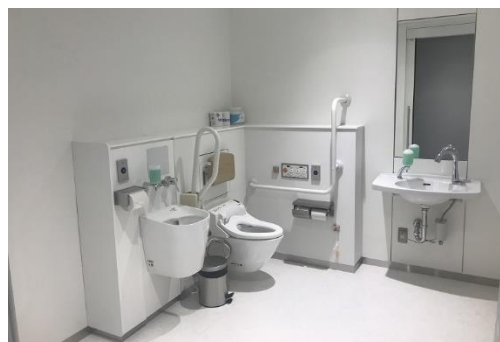
多目的トイレ (水戸市庁舎)
