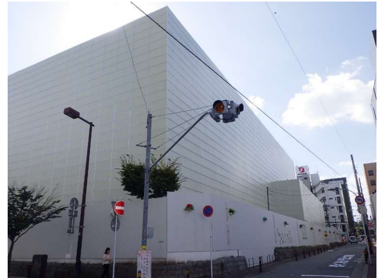
防音パネル設置完了
