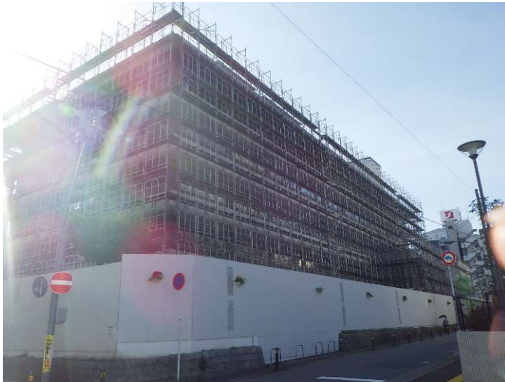
足場組立状況
