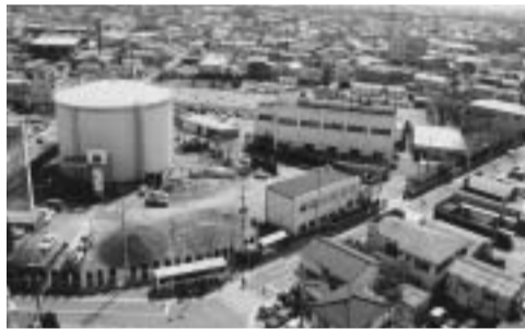
中央浄水場全景
