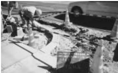
舗道整備工事
