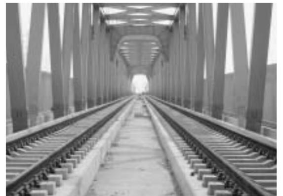
【レールの敷設工事が完了した中川橋りょう】
