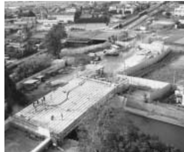
圻三郷線の圻川橋梁工事
