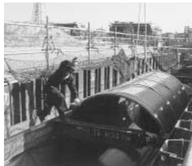
管渠布設状況
