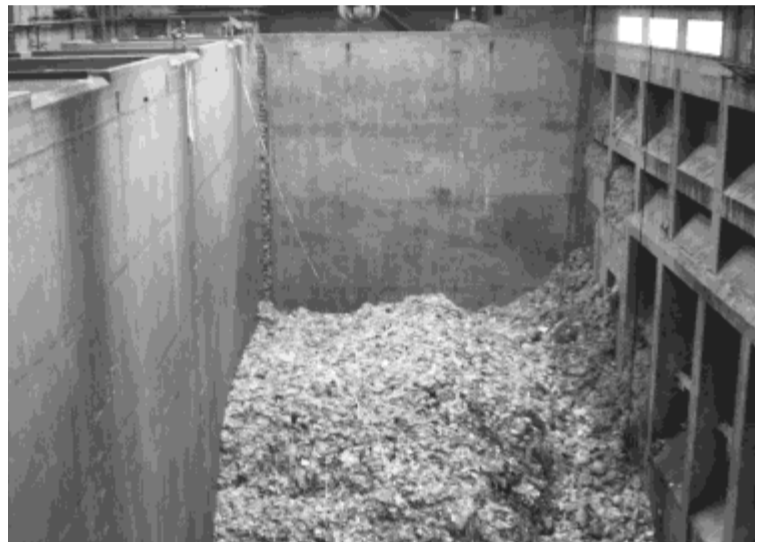
ごみピットの状況（平成16年12月）
