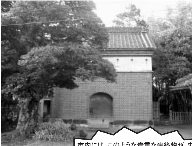
市内には、このような貴重な建築物が、まだ残っています。 (大正時代に築造された蔵)
