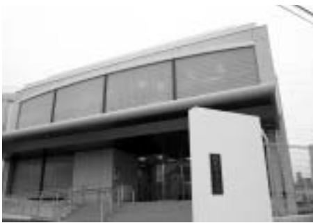
水道部の正面玄関
