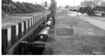
公共下水道雨水管渠築造工事
