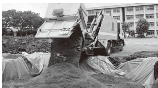
ロードスウィーパーによる表土除去
