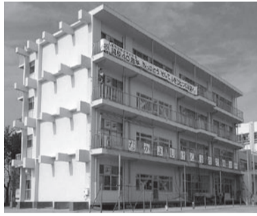
松之木小学校耐震補強および大規模改修工事
