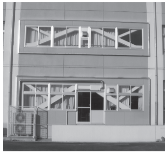
枠付鉄骨ブレース設置
