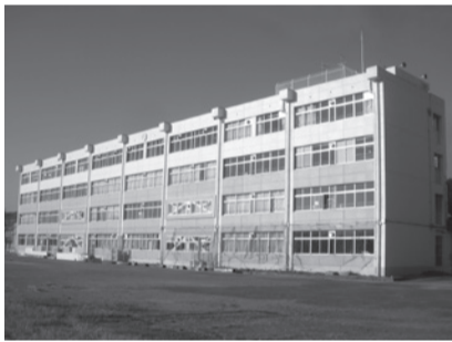
潮止中学校耐震補強および大規模改修工事
