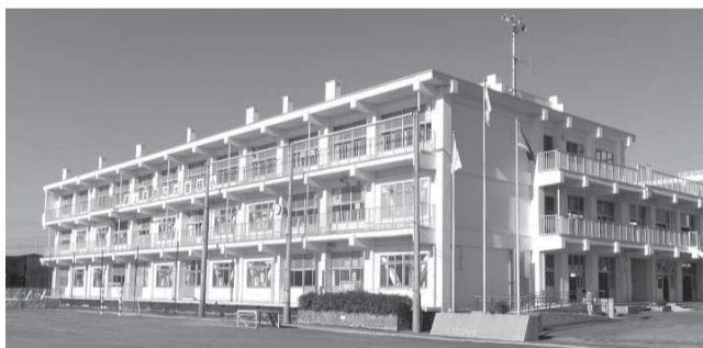
市債を活用して耐震補強した大曾根小学校
