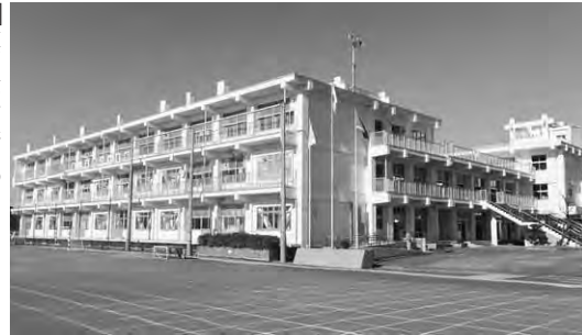
改修工事を行った大曾根小学校
