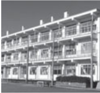
大曽根小学校耐震補強・大規模改修工事
