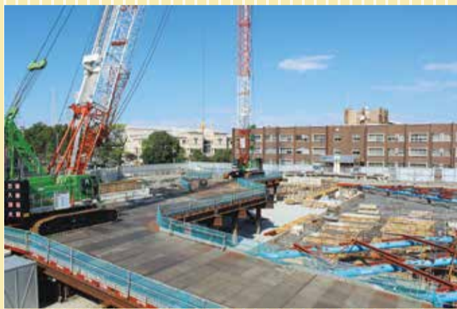
新庁舎工事現場全体
